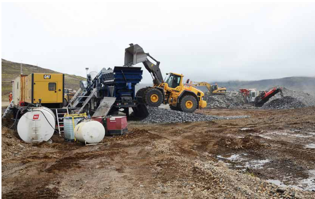
↓ Miklar framkvæmdir á Borgarfjarðarvegi (94).
