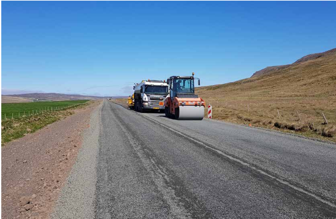
Laxárdalsvegur (59). Endurbygging vegarins frá Gröf að Lambeyrum.
