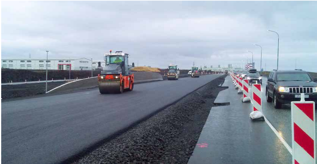
↑ Ný akrein á Reykjanesbraut (41) malbikuð en unnið var að tvöföldun Reykjanesbrautar í Hafnarfirði árið 2019.
